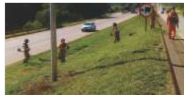
Conservação contínua da rodovia
