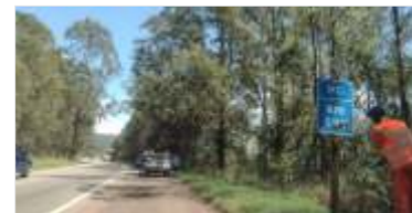
Conservação contínua da rodovia
