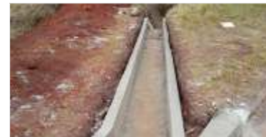
Recuperação de drenagem
