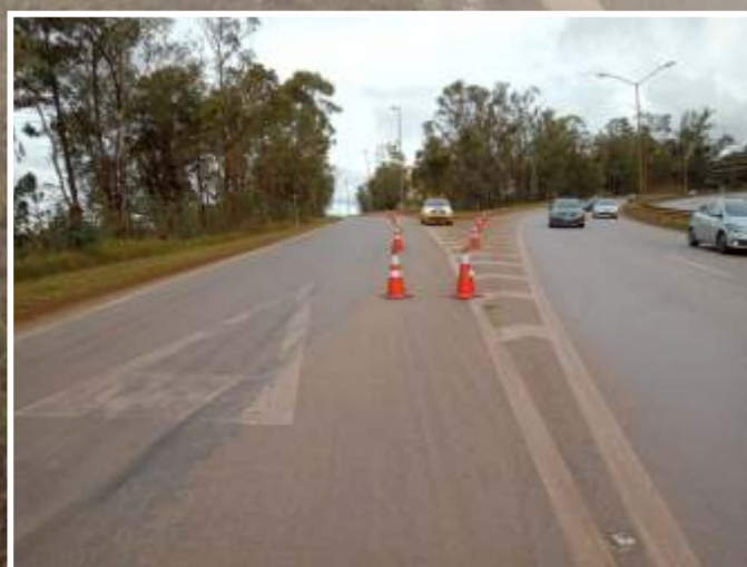
Canalização de tráfego aplicada na região do Aphilville, em Nova Lima. Melhoria da trafegabilidade na volta do feriado.
