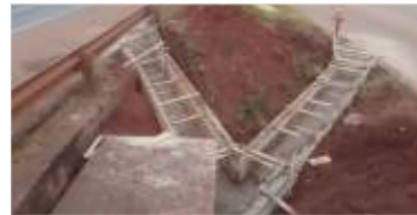
Recuperação de drenagem
