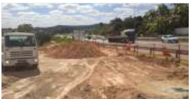
Preparação da área das rampas
