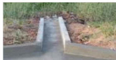
Reparo em drenagens
