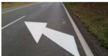
Pintura de faixas
