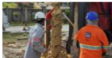
Perfuração para cravação de estacas
