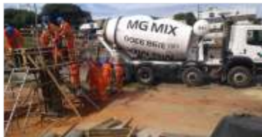
Concretagem dos pilares
