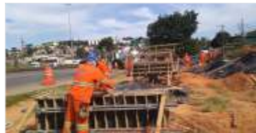
Concretagem dos pilares
