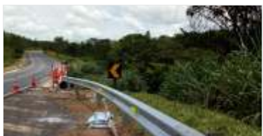
693 m de novas defensas metálicas
