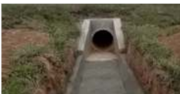
4.071 m de reparo em drenagens
