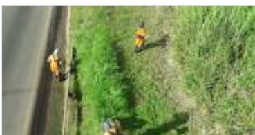
Conservação contínua da rodovia
