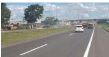
246 km de asfalto novo
