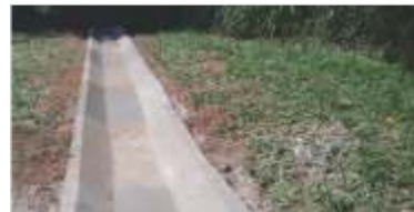
3.635 m de reparo em drenagens
