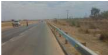
3.954 m de novas defensas metálicas
