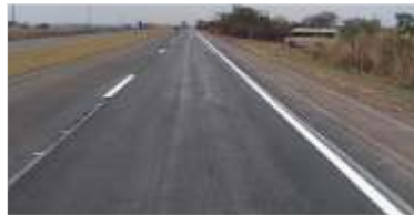
31 km de asfalto novo
