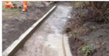
649 m de reparo em drenagens
