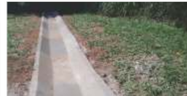
4.937 m de reparo em drenagens
