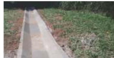
2.315 m de reparo em drenagens
