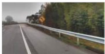
2.100 m de novas defensas metálicas
