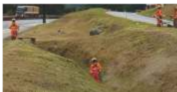
Conservação contínua da rodovia
