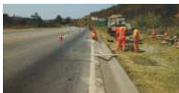
2.718 m de reparo em drenagens
