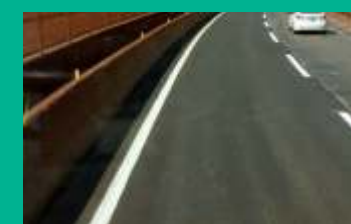
Melhoria de asfalto e sinalização
