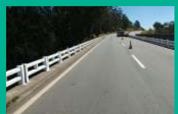
Caiçação de pontes e viadutos
