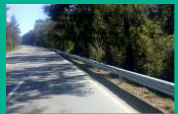
Instalação de proteção metálica
