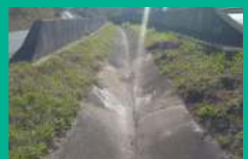
Limpeza de canaletas
