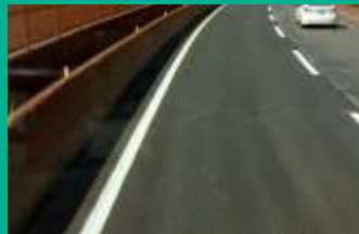
Melhoria de asfalto e sinalização
