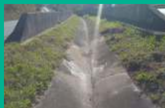
Limpeza de canaletas
