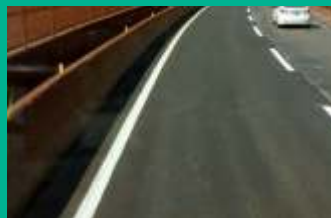
Melhoria de asfalto e sinalização
