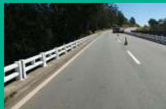
Caiçação de pontes e viadutos
