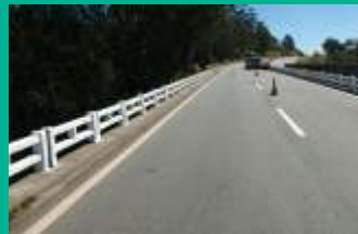
Caiçação de pontes e viadutos
