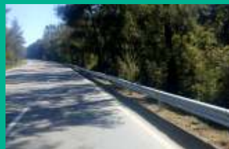
Instalação de proteção metálica
