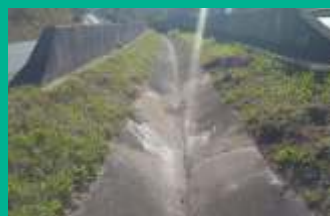
Limpeza de canaletas
