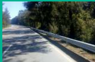
Instalação de proteção metálica
