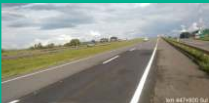
Asfalto recuperado em 17,9 quilômetros de pistas
